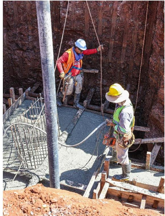
EXCAVACIÓN, ARMADO Y VERTIDO DE HORMIGÓN EN ZAPATAS
