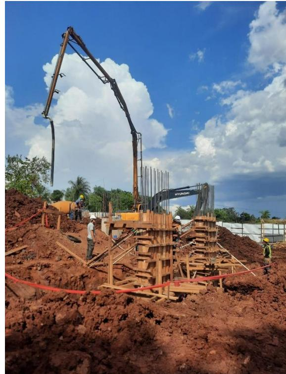
ARMADO, ENCOFRADO Y VERTIDO DE HORMIGÓN EN FUSTES
